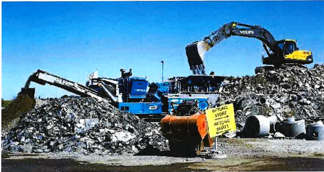
Kuva 3-18 Kuvassa on esimerkki betonijätteen murskauksesta
