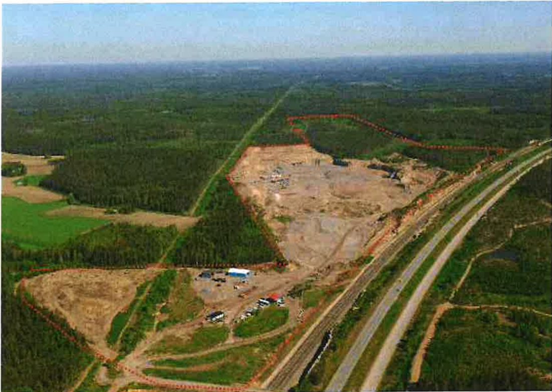
Kuva 1-1 Kuva kierrätysterminaalien alueesta. Punaisella katkoviivalla on rajattu hankealue.
