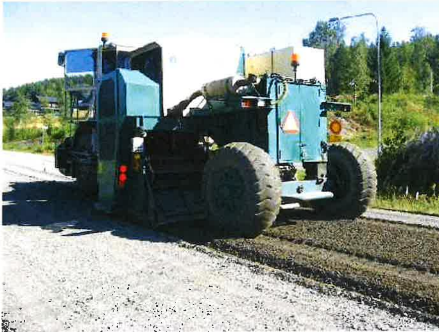
Kuva 3-19 Kuvassa esimerkki tuhkan hyötykäytöstä tierakenteessa käyttäen kerrostabilointitekniikkaa
