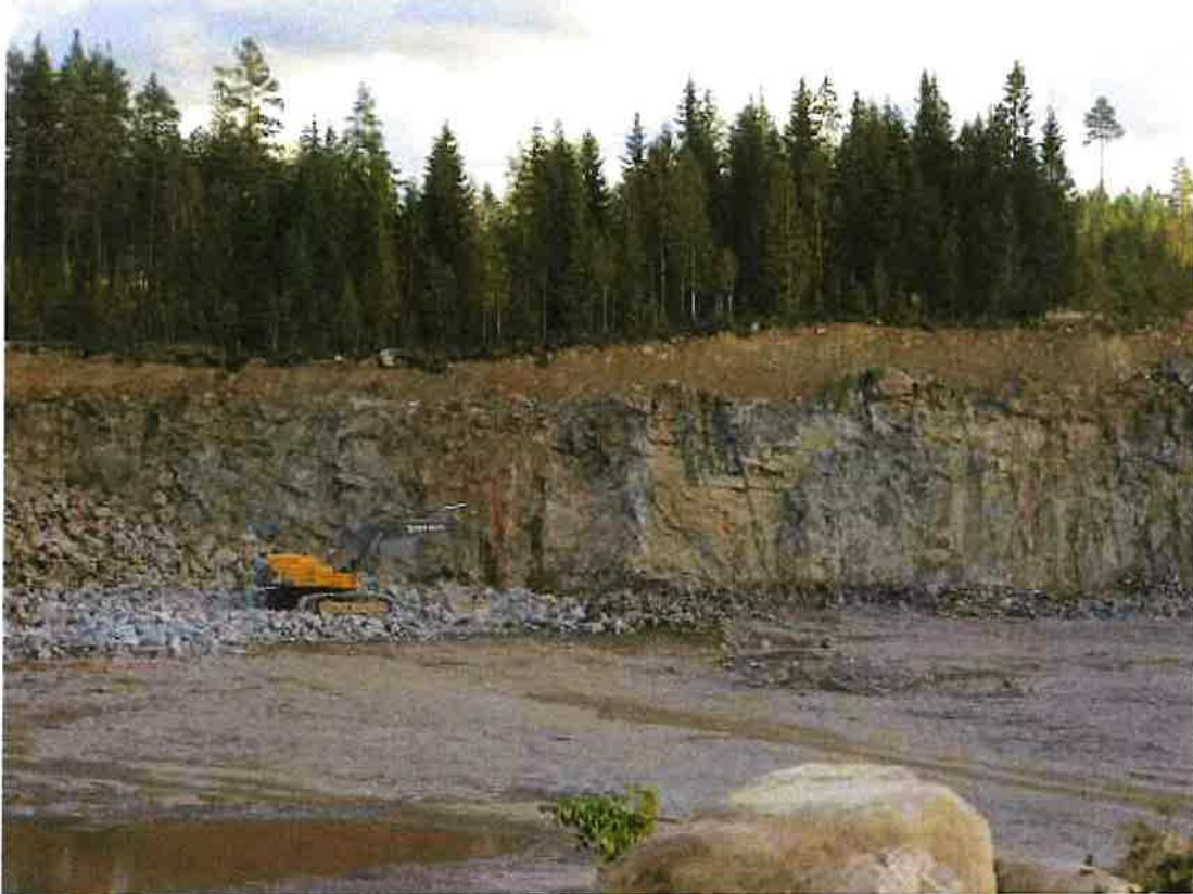
Kuva 3-10 Kuvassa louhittava rinta, josta rikotettu louhe kuljetetaan murskattavaksi
